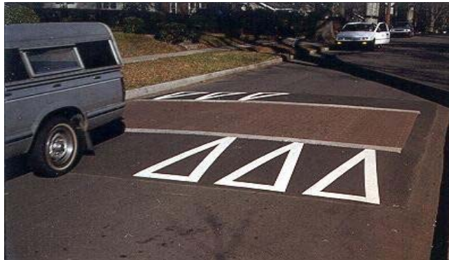
รูปที่ 6-1 ลูกเนินชะลอความเร็วแบบโค้งพาราโบลา
